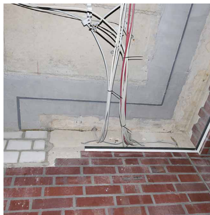
Abb. 42 + 43: Raumseitig aufgebrachtes Dehnfugenband mit ausgebildeter Zugzone
