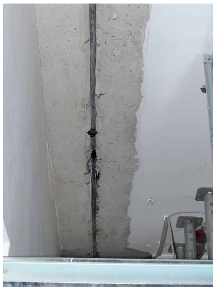
Abb. 38 + 39: Dehnfugeninjektion mittels Profilschlauch, Injektionsnadeln und Polyurethanharz
