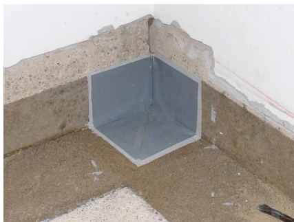
Abb. 26 + 27: Handwerklich gefertigte Formstücke für Detailabdichtungen
