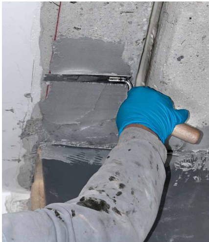
Abb. 40 + 41: Einbetten des Dehnfugenbands in Epoxidharzkleber
