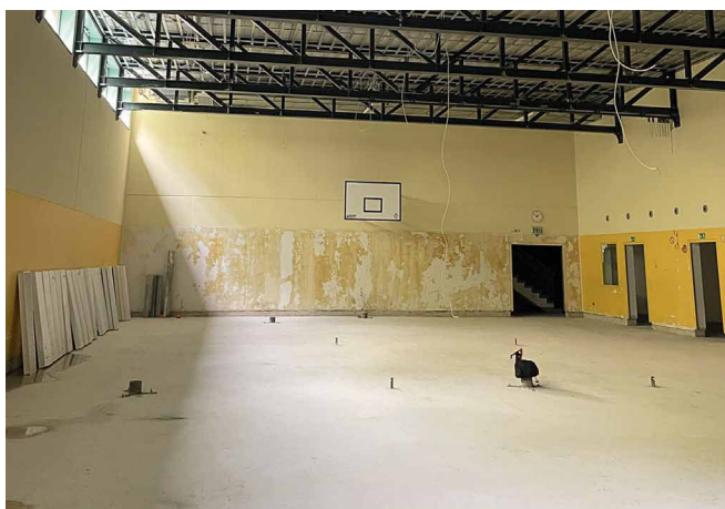
Abb. 10+11: Sporthalle und Nebenraum mit ausgebauter Fußbodenkonstruktion
