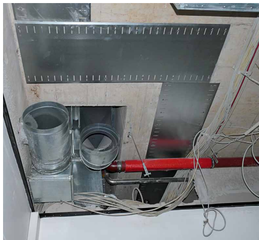
Abb. 44 + 45: Objektspezifisch gefertigte dehnfugenüberdeckende Stützbleche
