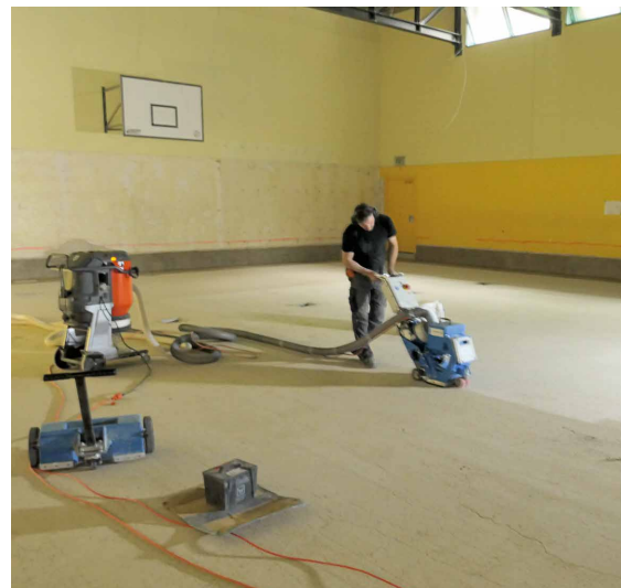
Abb. 23: Kugelstrahlen der Betonbodenoberfläche
