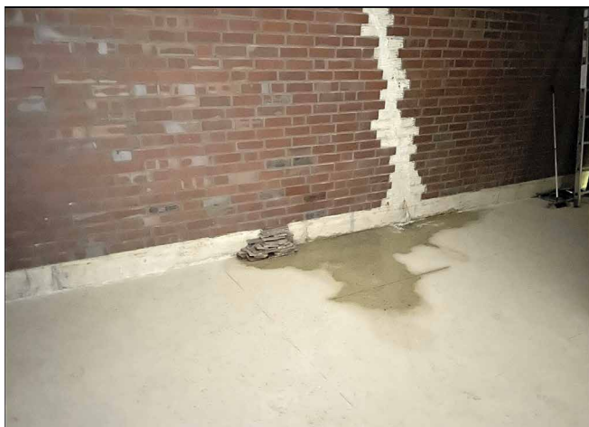
Abb. 17 + 18: Wassereintritt durch einen Riss in der Betonwand und über einen gefügestörten Betonbereich der Bodenplatte
