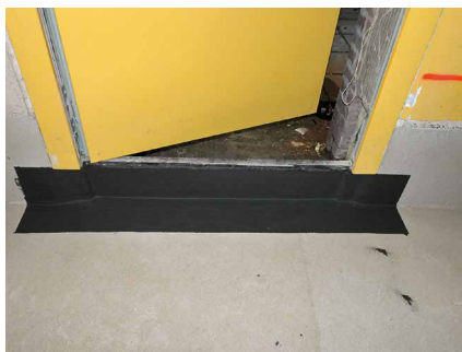
Abb. 51 + 52: Nachträglich abgedichtete Türschwelle des Notausgangs
