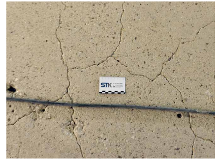
Abb. 46: Nach Kugelstrahlen sichtbar gewordene Risse in der Betonbodenplatte
