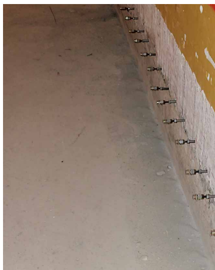
Abb. 21 + 22: Rissinjektion und Injektion im Bereich des innen liegenden Fugenbandes
