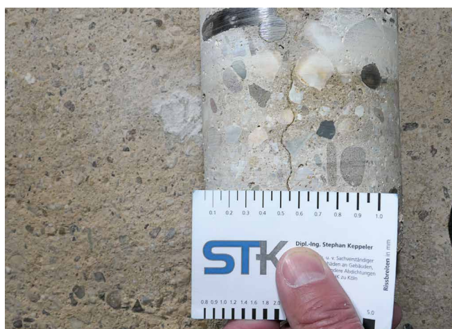
Abb. 17 + 18: Wassereintritt durch einen Riss in der Betonwand und über einen gefügestörten Betonbereich der Bodenplatte
