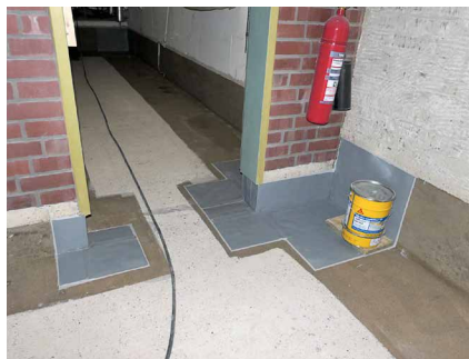
Abb. 26 + 27: Handwerklich gefertigte Formstücke für Detailabdichtungen
