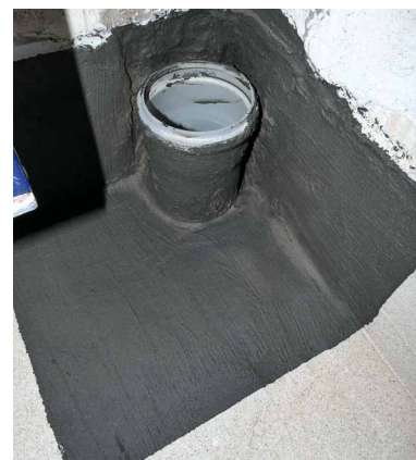
Abb. 49 + 50: Abdichtung von Rohrdurchdringungen mit einer flexiblen polymermodifizierten Dickbeschichtung
