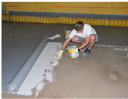
Abb. 32 + 33: Flächenabdichtung mittels Epoxidharzkleber und Kunststoffolie
