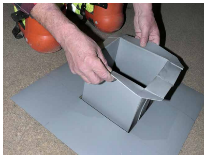
Abb. 28 + 29: Handwerklich gefertigte Formstücke für Detailabdichtungen
