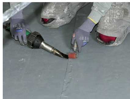
Abb. 35: ... Verschweißen von Kunststoffbahnübergängen
