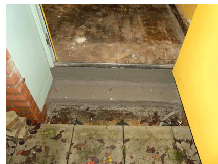
Abb. 51 + 52: Nachträglich abgedichtete Türschwelle des Notausgangs
