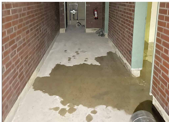
Abb. 17 + 18: Wassereintritt durch einen Riss in der Betonwand und über einen gefügestörten Betonbereich der Bodenplatte
