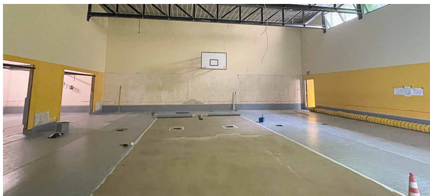
Abb. 36 + 37: Schutzschicht aus Epoxidharz mit Quarzsandabstreuerung
