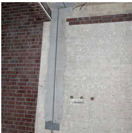
Abb. 42 + 43: Raumseitig aufgebrachtes Dehnfugenband mit ausgebildeter Zugzone
