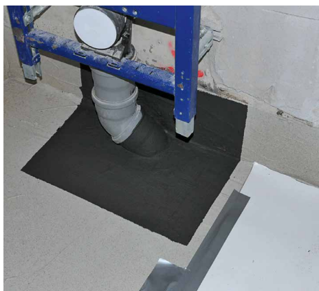
Abb. 49 + 50: Abdichtung von Rohrdurchdringungen mit einer flexiblen polymermodifizierten Dickbeschichtung
