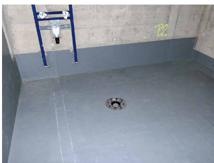
Abb. 47 + 48: Anschluss von Bodenabläufen an die Kunststofffolienabdichtung mittels Flanschkonstruktion
