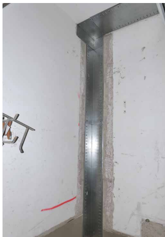
Abb. 44 + 45: Objektspezifisch gefertigte dehnfugenüberdeckende Stützbleche
