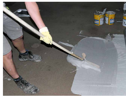
Abb. 32 + 33: Flächenabdichtung mittels Epoxidharzkleber und Kunststoffolie
